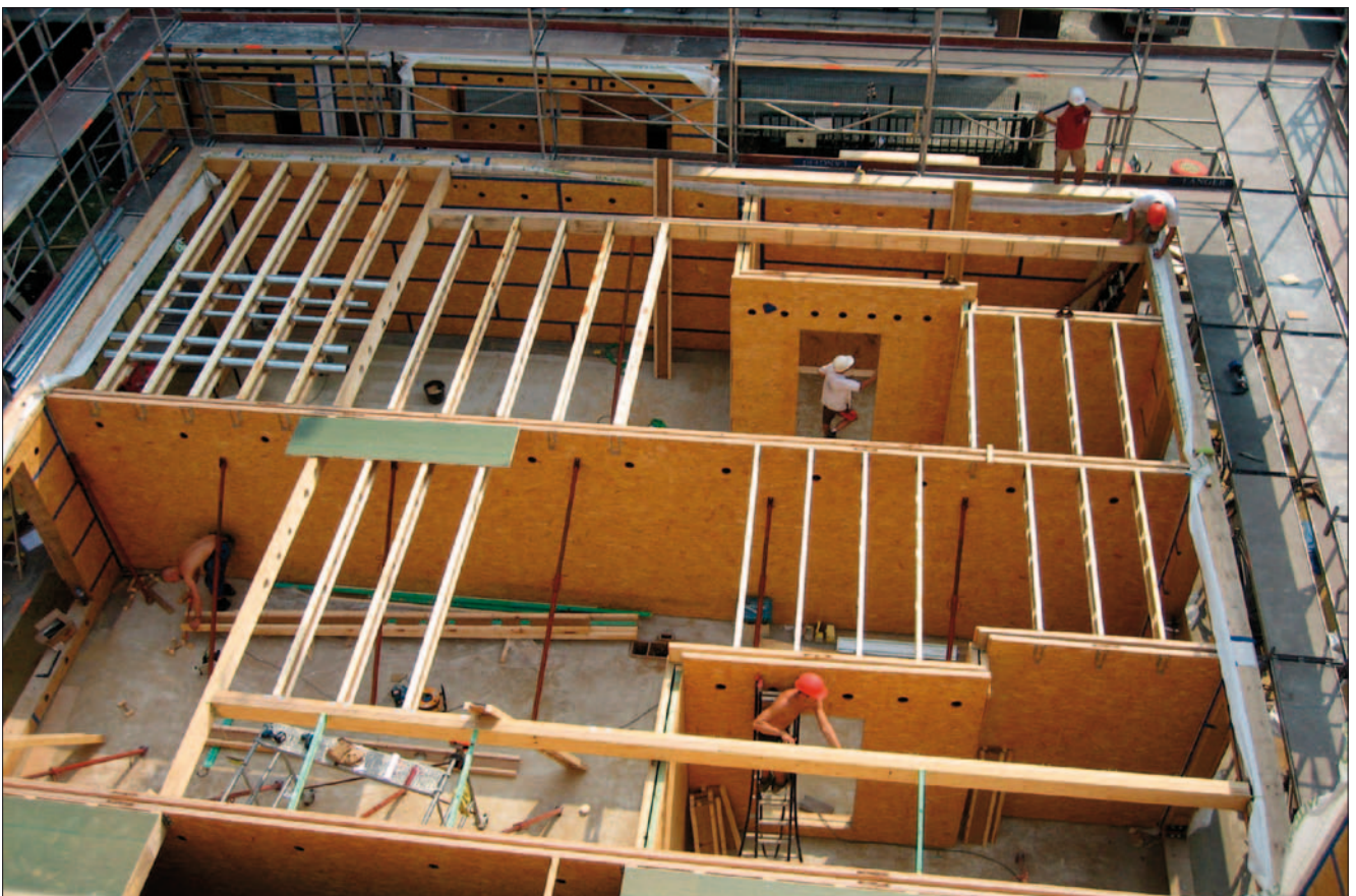
HOUTSKELET – Veel lichter, en dus zijn de funderingswerken veel minder ingrijpend.
