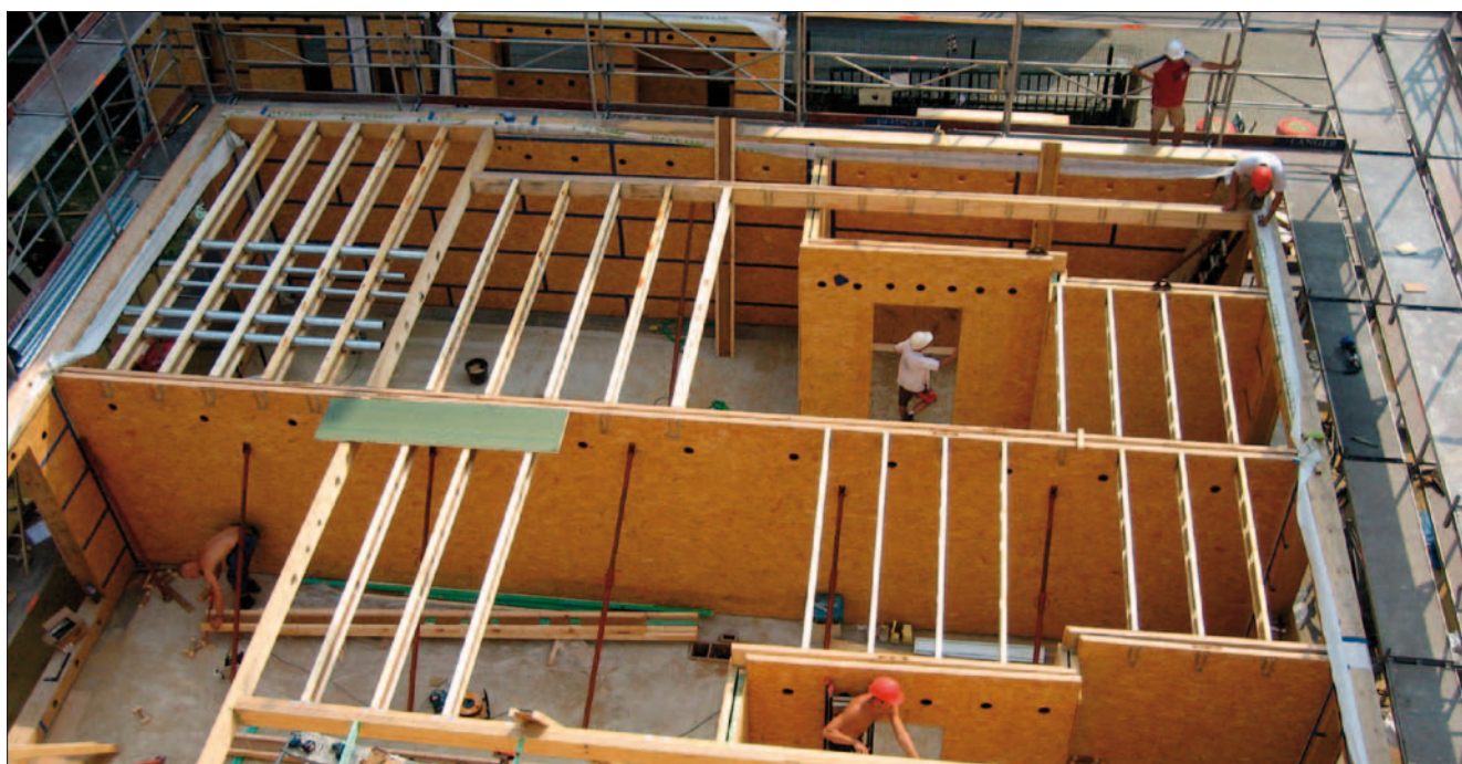
OSSATURE BOIS – La légèreté des structures a permis de limiter l'impact des fondations.
